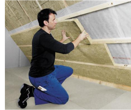
Untersparrendämmung
