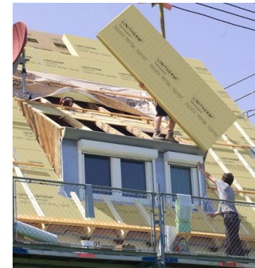
Aufsparrendämmung
